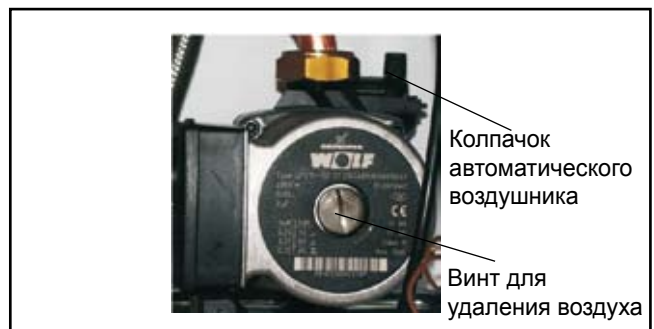
Рис.: Автоматический воздушный клапан на насосе котлового контура.
