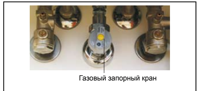
Рис.: Запорная арматура
