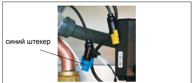
Рис.: Синий штекер для подключения датчика температуры водонагревателя
