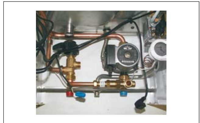
Рис.: Блок подключения демонтирован
