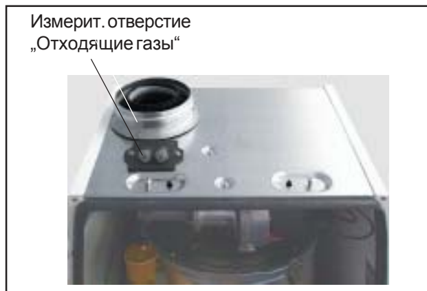
рис.: Измерение отходящих газов на котле с открытым корпусом
